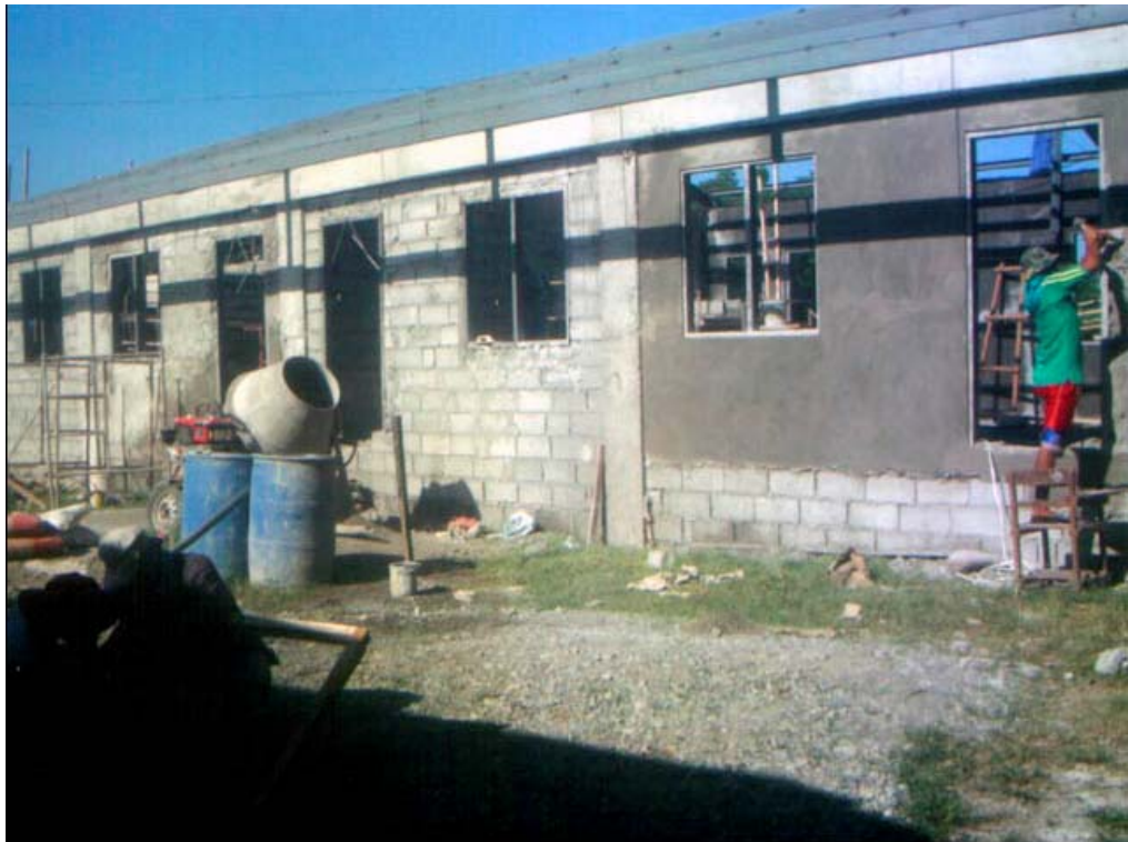
Um bei einer Überschwemmung die Klassenzimmer zu schützen, wurde das Innere des Gebäudes aufgeschüttet. Die Türen befinden sich 1m über dem gewachsenen Boden.
