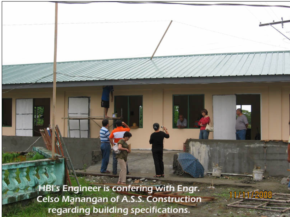
Inspektion des Schulgebäudes am 11. November 2008
