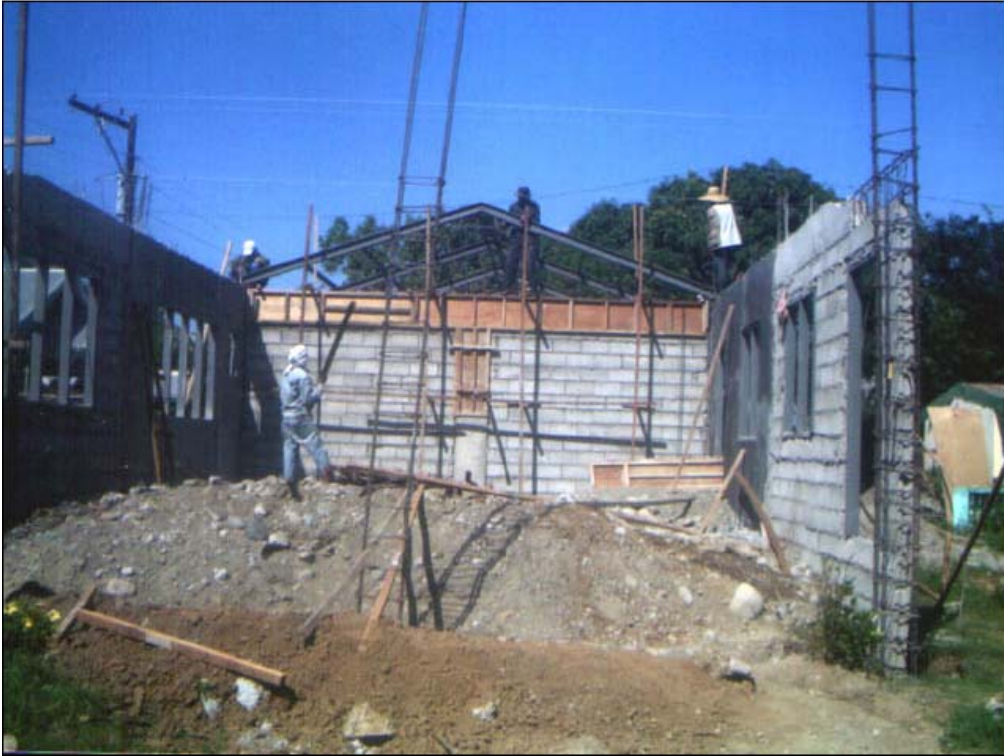
Um bei einer Überschwemmung die Klassenzimmer zu schützen, wurde das Innere des Gebäudes aufgeschüttet. Die Türen befinden sich 1m über dem gewachsenen Boden.
