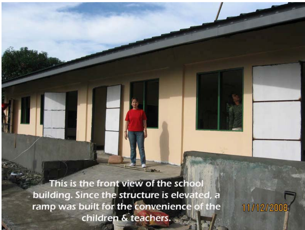
Frontansicht des Schulgebäudes. Um die Höhendifferenz zu überwinden wurde eine Rampe gebaut.
