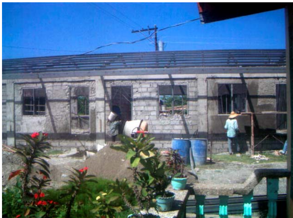
YLENIA Gebäude im Rohbau am 23. Oktober 2008
